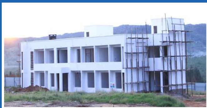
Uhakika wa Malazi: Jengo jipya la malazi lililojengwa chini ya Mradi wa HEET katika kampasi ya UDSM Kagera.
