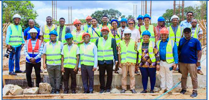
Waandishi wa habari pamoja na baadhi ya wajumbe wa Kitengo cha Utekelezaji wa Mradi wa UDSM walipotembelea eneo la ujenzi wa majengo ya HEET-UDSM, Mkoa wa Lindi mwishoni mwa mwaka 2024
